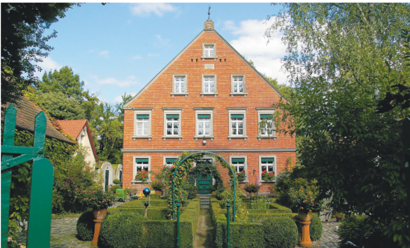
Die Westansicht der „Oberen Mühle“.
