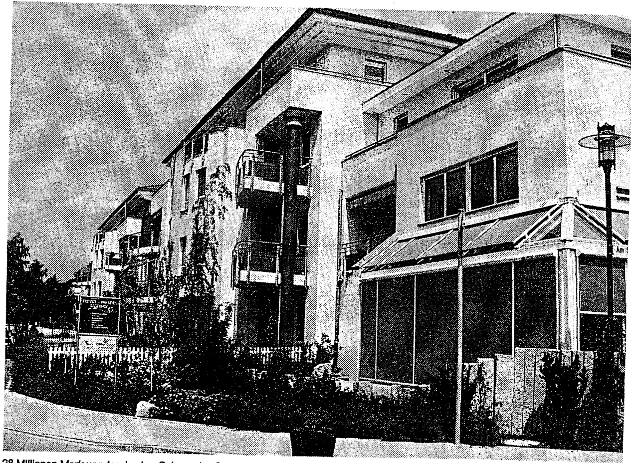
28 Millionen Mark wurden in den Schwander Seniorenhof investiert. Die Bauzeit umfaßte zweieinhalb Jahre, die Pläne für eine Erweiterung liegen bereits vor. Foto: Weidler
